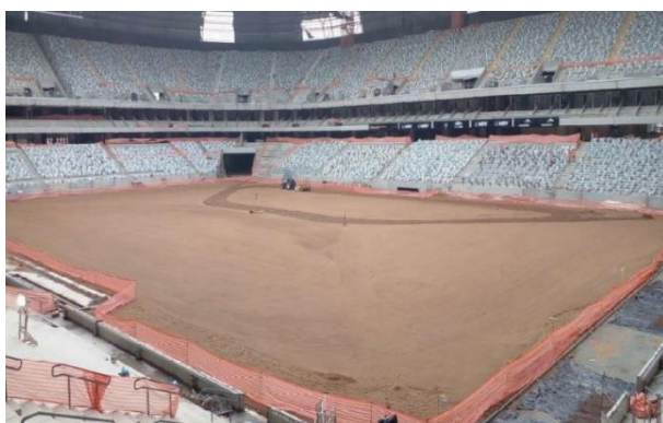
Resultado Parcial do Nivelamento a Laser da Camada de Top Soil - 12/11/2022
